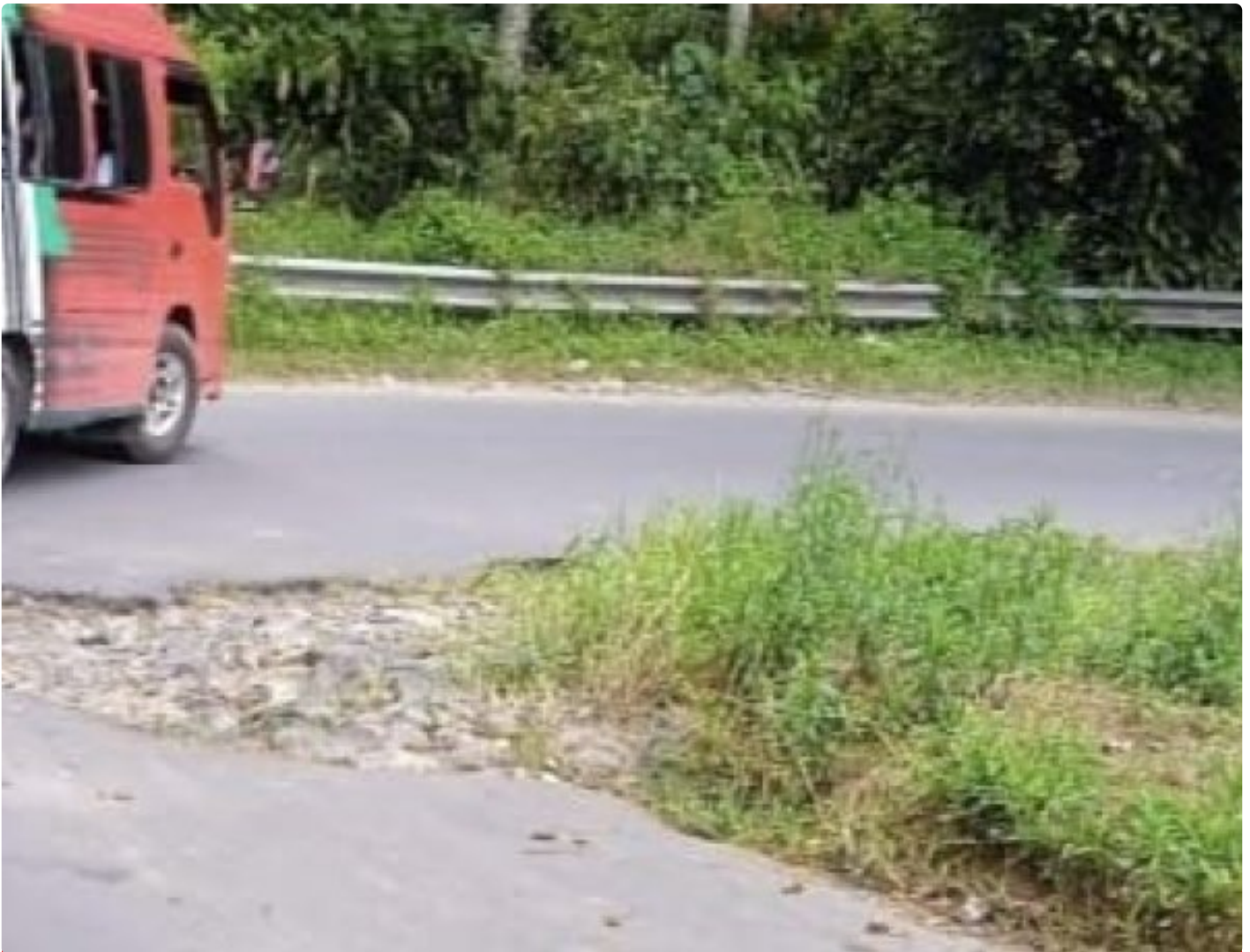
Jalan Provinsi ke Pelabuhan Penyeberangan Tigaras
